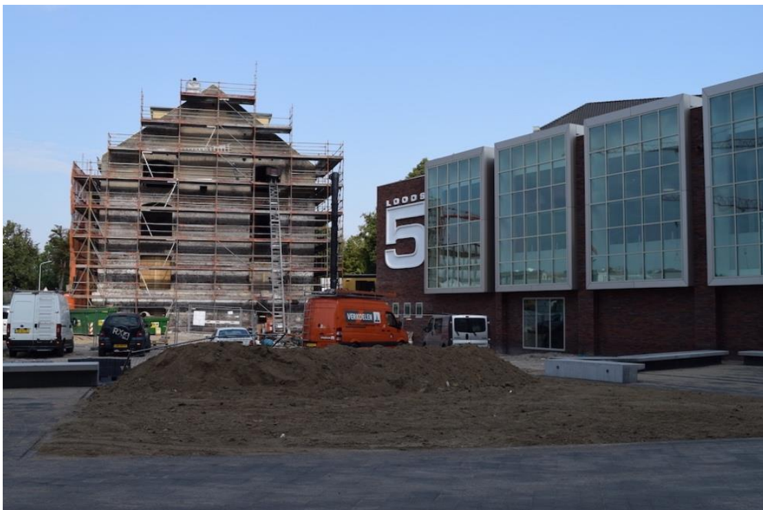
Vorbereiding aanleg P. Regoutplein
