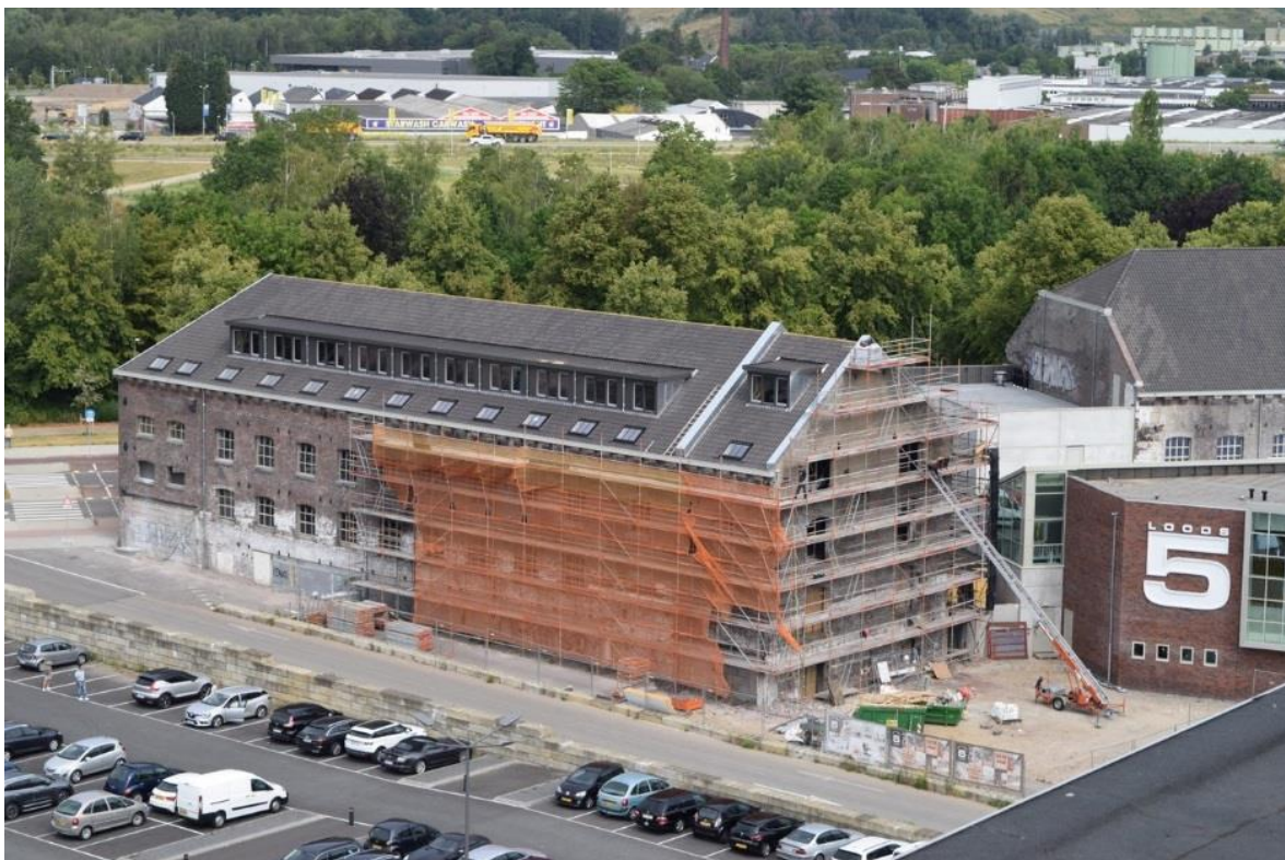
Realisatie dakkapellen aan zuidkant Spoorgebouw
